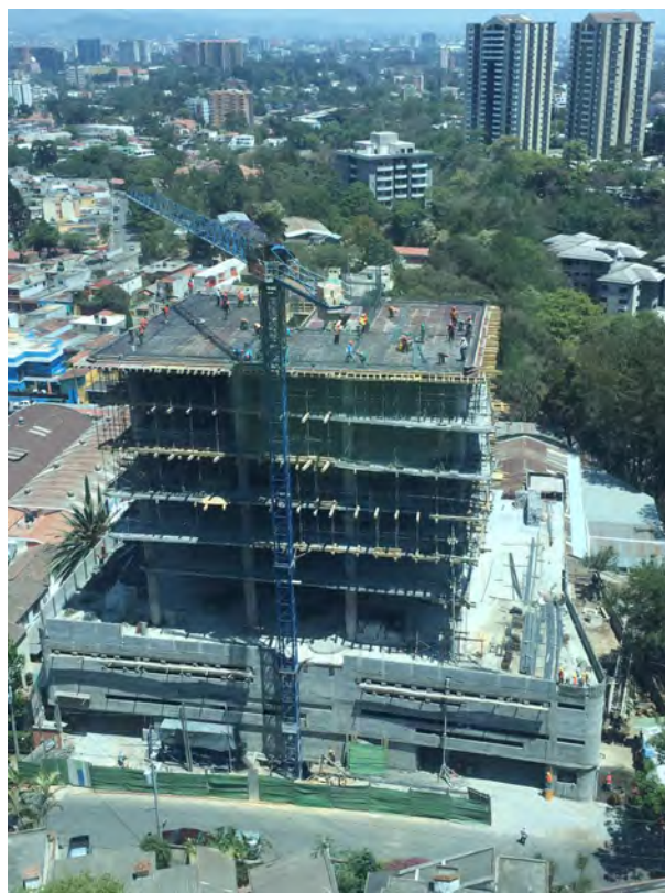
Construcción Sede AMM abril - 2017
