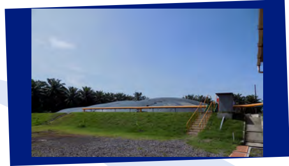
Planta de Generación GABIOSA
