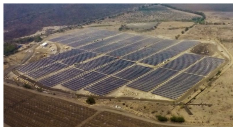
Central Solar Fotovoltaica de SIBO, S.A.
